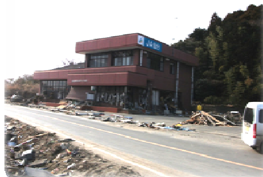
津波により全壊した七ヶ浜支店(七ヶ浜町)
